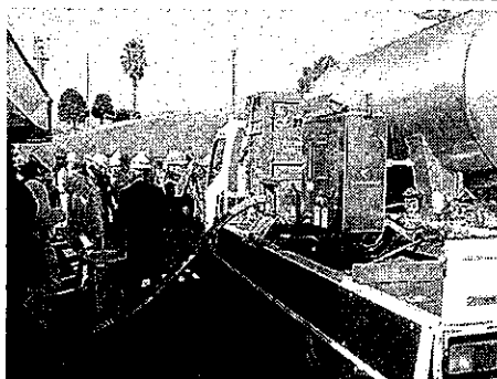
デリバリーユニットで現場搬入
