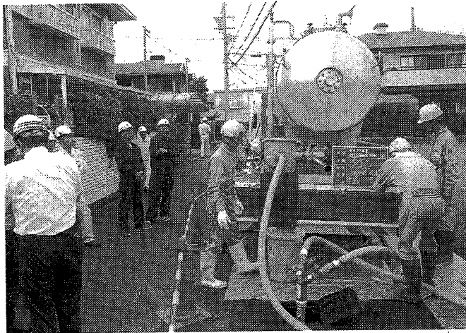
管路上にφ50のサドル付き分水栓を設置しSISを注入
