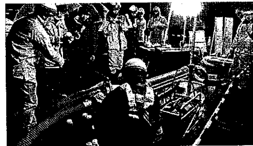
回収口でマンガンなど除去を視認(同上)
