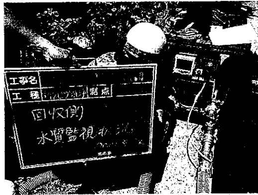
回収側での水質監視状況
