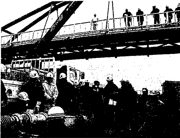
初採用のアイスピクでφ300の放流管を洗浄した
