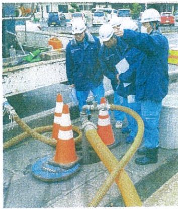
空気弁からシャーベットを注入
