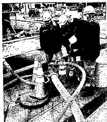
空気弁からシャーベットを注入
