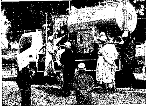
注入地点の様子
