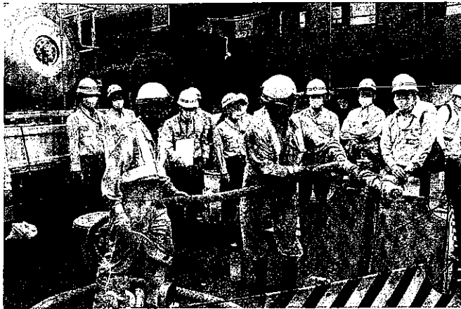
搬入した特殊アイスシャーベットを注入(左奥はデリバリーユニット車)
