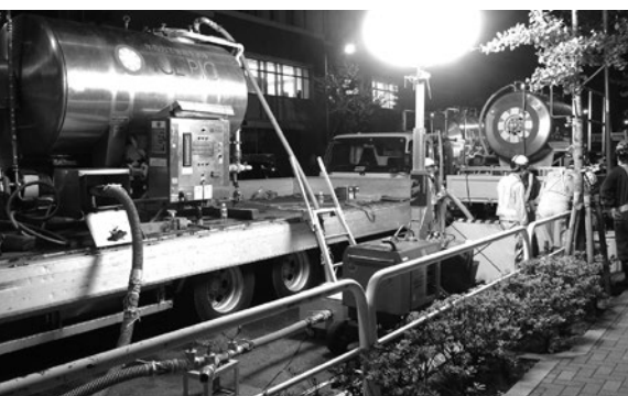
デリバリーユニット3台で特殊アイスシャーベツト(SIS)を搬入
