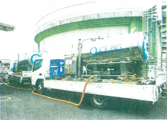
配水池内に注入口を設置
