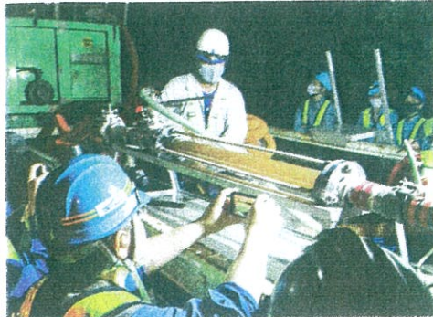
排出口近くにアクリル管を設置
